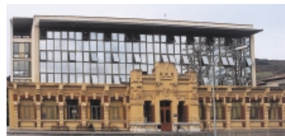
Asilo de ancianos del Ayuntamiento de Piloña. Infiesto. (Asturias).
